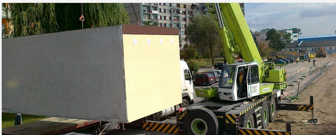
Rysunek 12 Możliwe jest również wykonanie modułów na gotowo w hali produkcyjnej.
