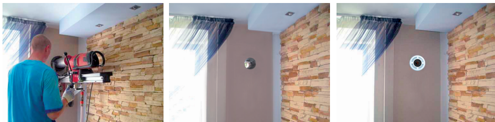
Rys 5. Wzór montowania układu wentylacji dolotowo-wyciągowej PRANA-150.
